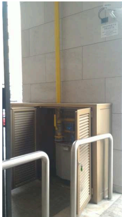
Valvola di intercettazione del gas
